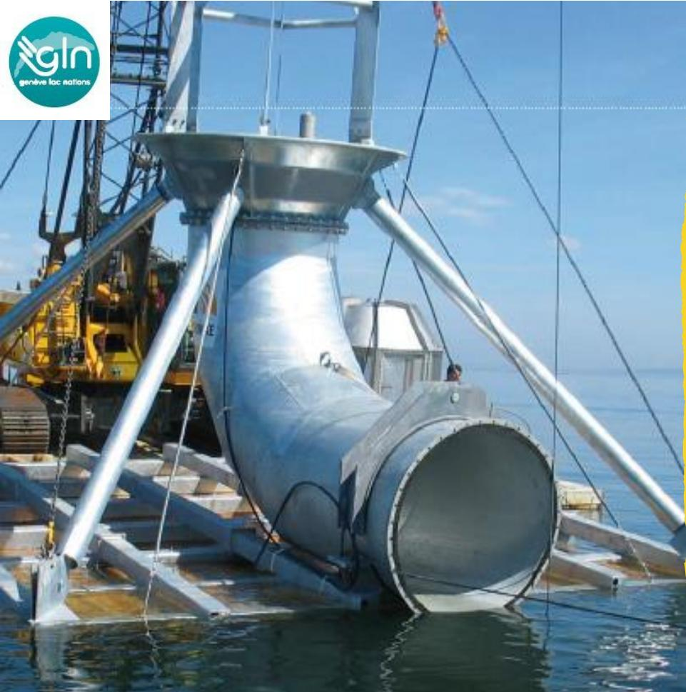
Depuis 2008, GLN, un réseau de froid renouvelable de 18 MW, assurant le rafraîchissement direct en freecooling et le chauffage basse température par le biais de pompes à chaleur, pour les bâtiments à haute performance énergétique du quartier des Nations (ONU, Comité International de la Croix-Rouge, OMC, BIT, etc.)
