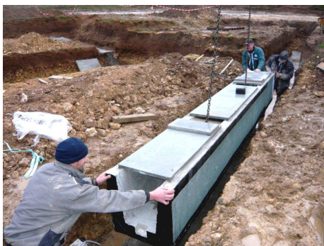
(a) Vue pendant la pose
