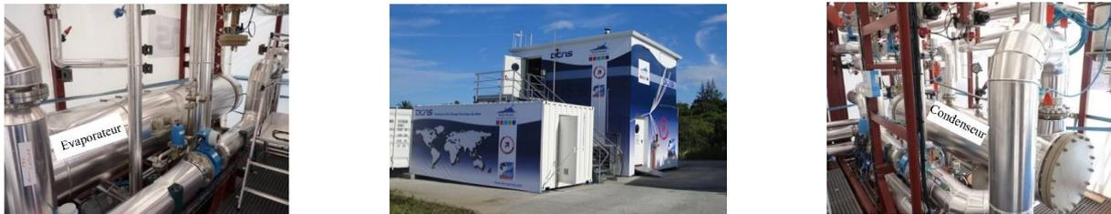
Figure 2 : Installation du prototype à terre, évaporateur (à gauche), vue extérieure d'ensemble (au centre) et condenseur (à droite).
