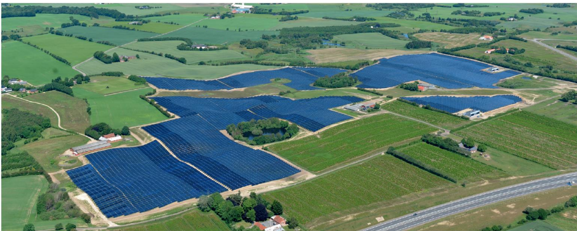
Figure 5 : Stockage solaire thermique saisonnier du réseau de chaleur de Silkeborg (DK) [14]
