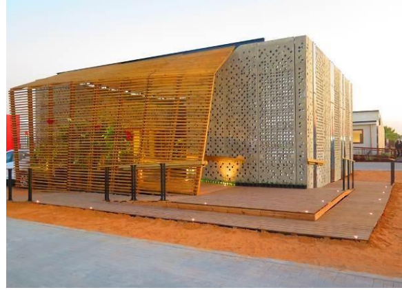
Figure 1 : Plateforme expérimentale living lab BaityKool (BKlab) (vue façade nord)
