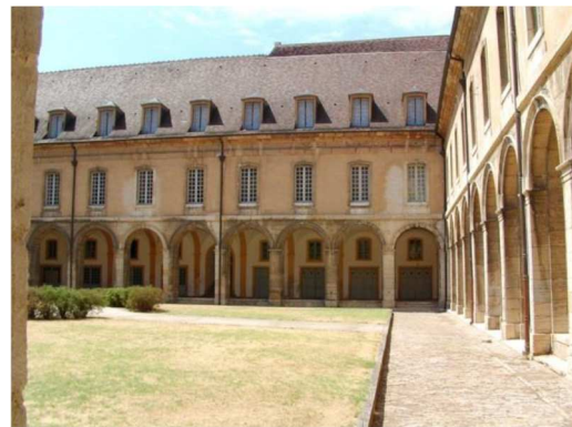
Figure 2 : Photographie de l'aile ouest du cloître où se trouvent les chambres rénovées au 1 er étage
