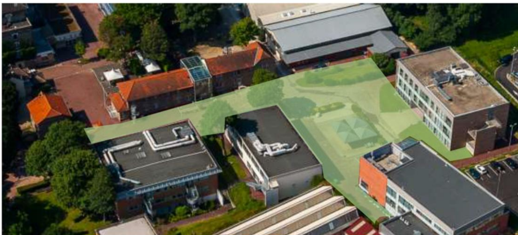
Figure 1 : Emprise du démonstrateur à l'ESTP, campus de Cachan.
