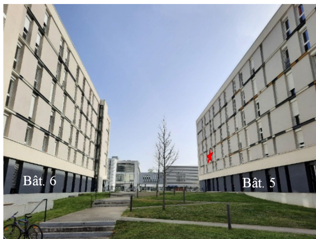
(b) Vue entre les bâtiments 5 et 6
