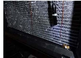
Figure 7 : Dispositif d'aspersion d'eau installé sur le condenseur
